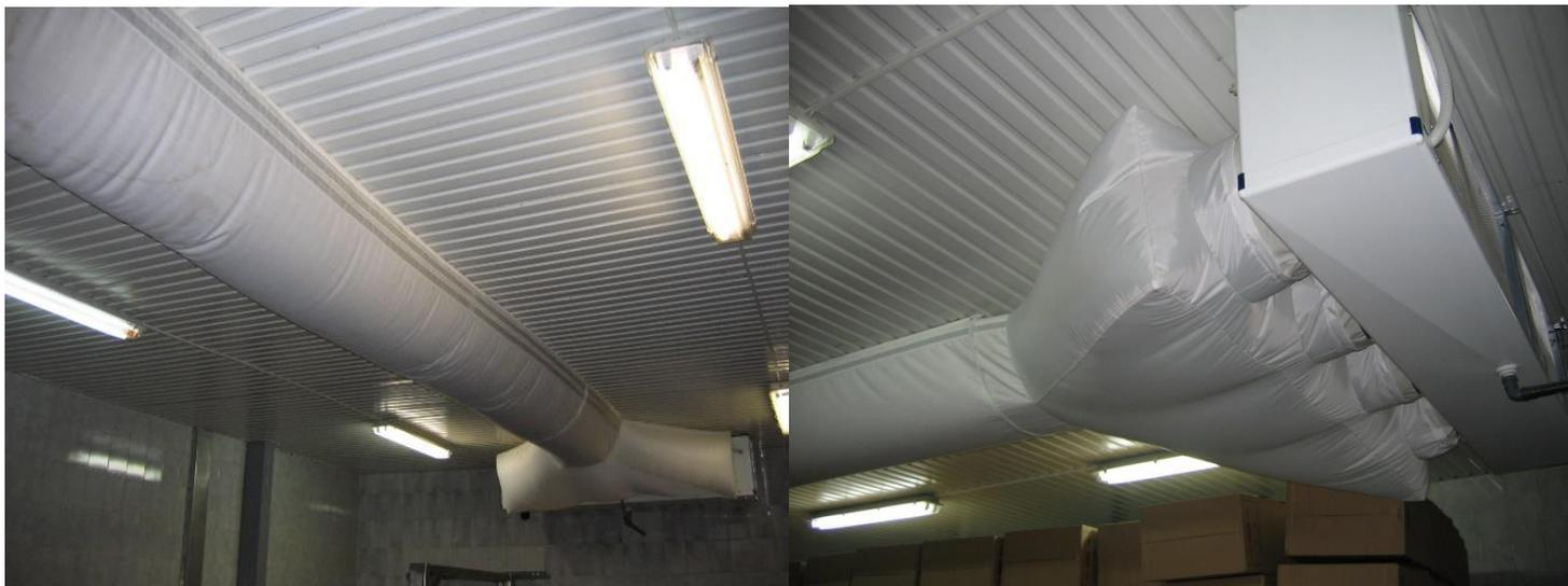
Полукруглые воздуховоды вставляются в алюминиевые профили, закрепленные к поверхности потолка, или подвешенные на шпильках. В основном расстояние между направляющими соответствует диаметру воздуховода. Если воздуховод комплектуется коллектором, то профиль необходимо начинать крепить с отступом от охладителя на 700-800мм. Т.к. глубина коллектора 800мм и он крепится на решетки вентиляторов и к воздуховоду.
