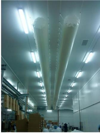
Воздуховод состоит из нескольких частей, которые соединяются между собой с помощью застежек-молний. В местах соединения пришиты бирки с информацией о номере отрезка воздуховода. Воздуховоды поставляются заказчику в мешках в собранном виде или поэлементно, в зависимости от длины и диаметра воздуховода.
